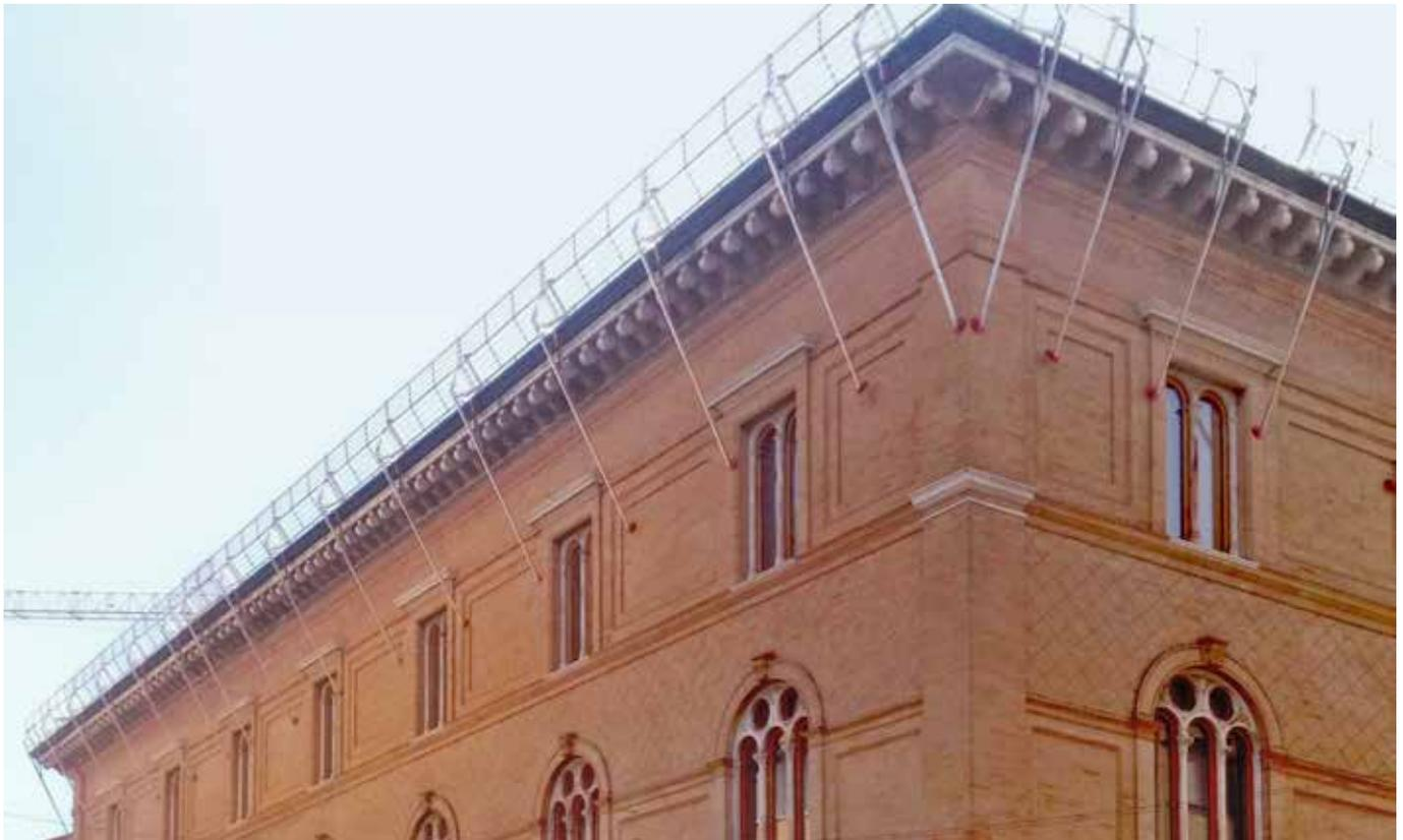
Das Geländer **Roof Safety System** ist ein innovatives Produkt im Bereich der kollektiven Schutzsysteme. Es besteht vollständig aus Aluminium und ist nach der europäischen Norm UNI EN 13374, Klasse C, zertifiziert, was die Verwendung auf Dächern mit einer Neigung von bis zu 60° ermöglicht. Es besteht aus einem 3 m langen Geländer, Konsolen und einem Bordbrett, so dass keine zusätzlichen Bretter erforderlich sind.
