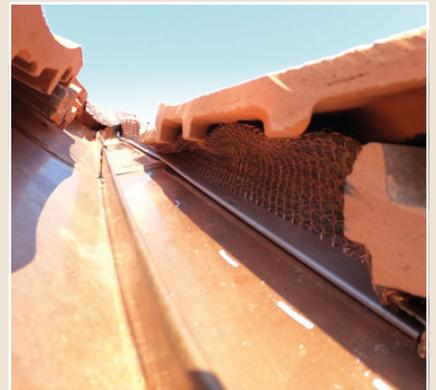
Bei grossen Öffnungen, kleinen Ziegelspickeln und maximaler Streckung des **Marder Protect™**, empfehlen wir den punktuellen Einsatz eines Montageklebers.
